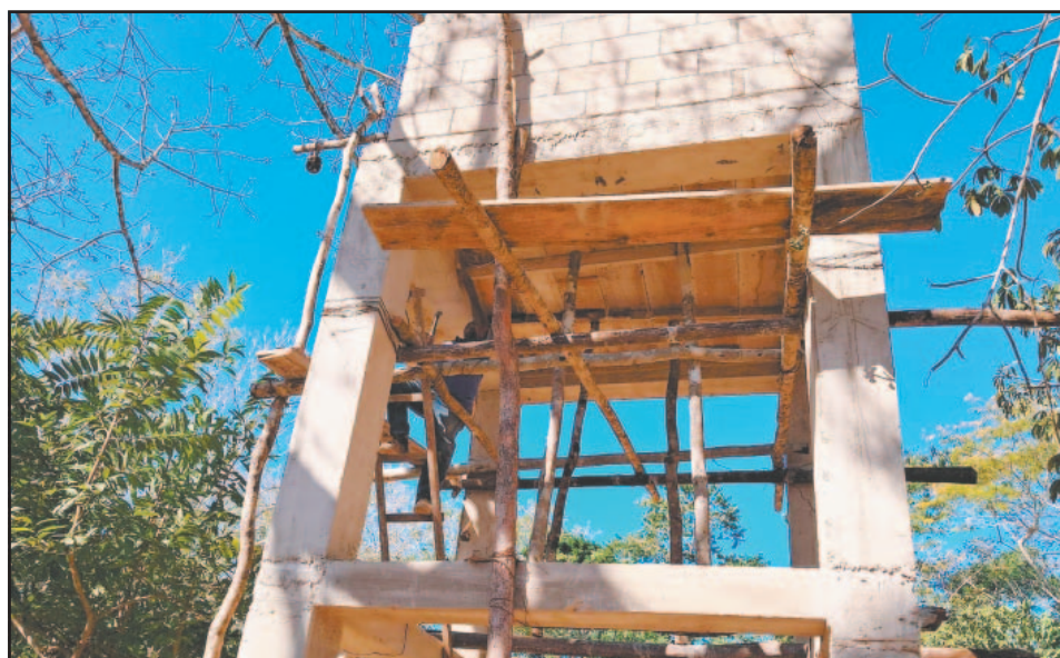
Fue construido un tanque elevado; en los próximos meses estará lista la conexión.
