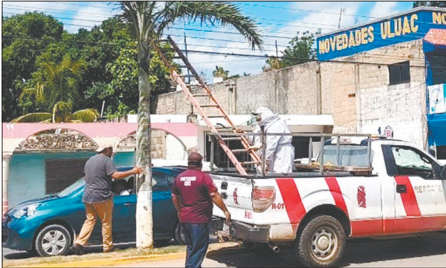
El reporte sobre el problema en la avenida principal se recibió a las 10:30 horas. Las maniobras tardaron unos cinco minutos. (Lusio Kauil)
