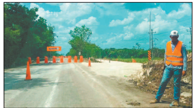
Trabajadores reparan el túnel formado por un deslave. (Fernando Olvera)
