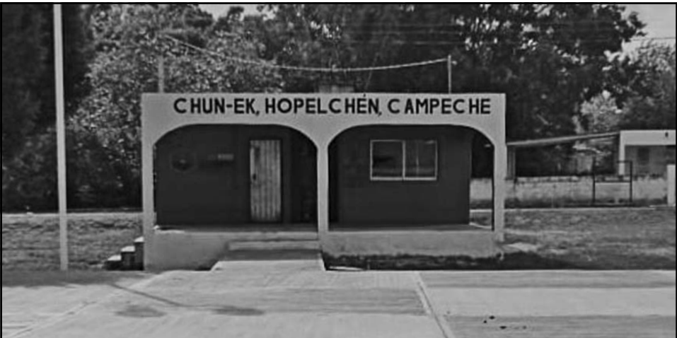
Se notificó del problema a la Conagua para que intervenga urgentemente. (Mauriel K.)
