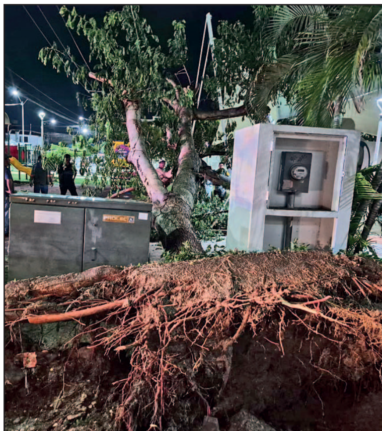
La planta fue arrancada de raíz junto con una parte del concreto.
