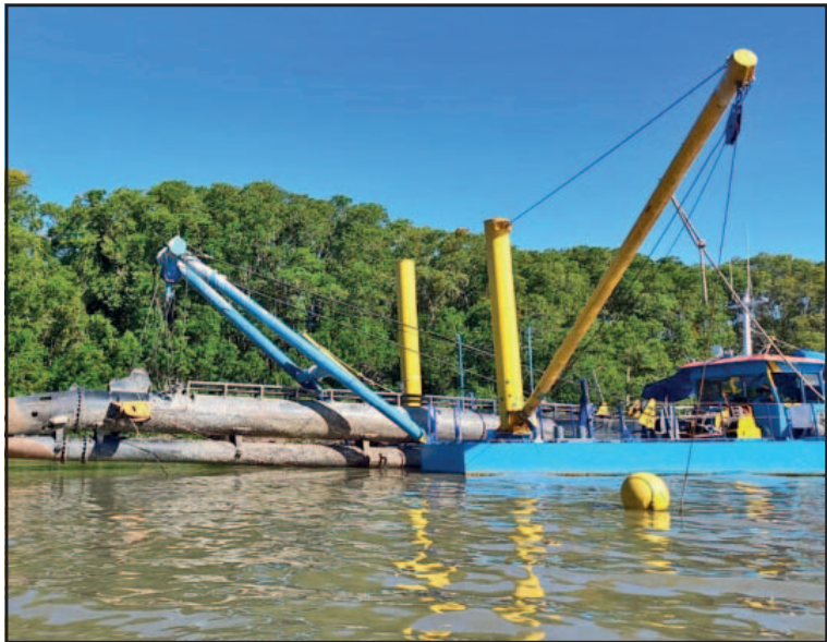
Las obras del año pasado incluyeron el dragado del río Palizada.
