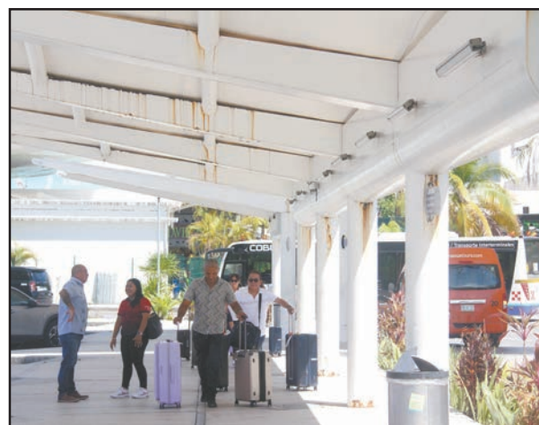
CORROSIÓN, pintura desprendida y soportes deteriorados afectan las estructuras metálicas de los andenes en el recinto aéreo.- (Henry Bretón)
