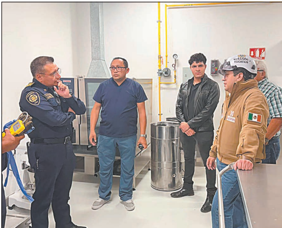
Tras la revisión de las instalaciones se descartó una fuga y no se reportaron personas lesionadas.
