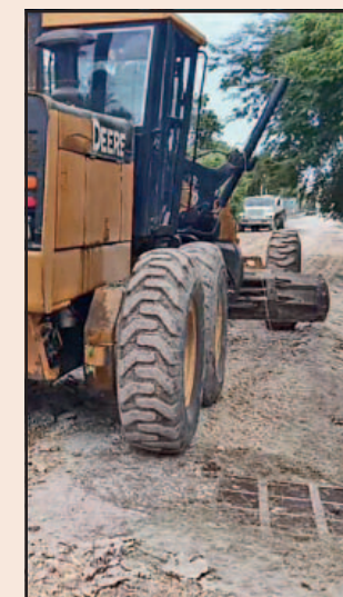
Se realiza el raspado para pavimentar. (POR ESTO!)
