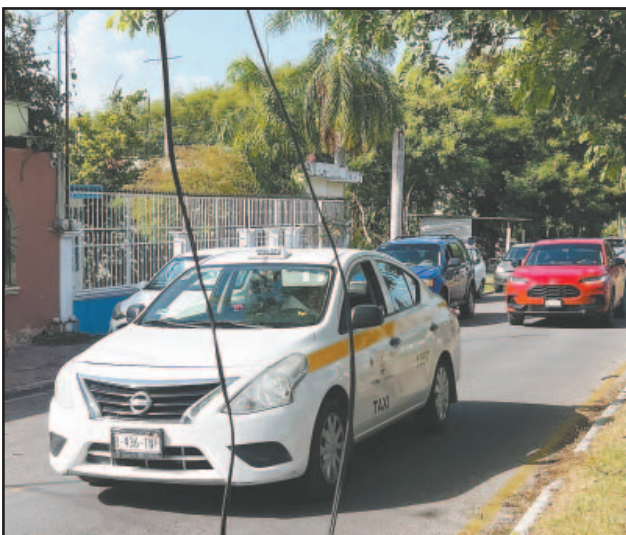
EL martes, un camión derribó el cableado y dejó sin servicio a la colonia; vecinos amagan con manifestarse si no hay solución.- (E. Martín)
