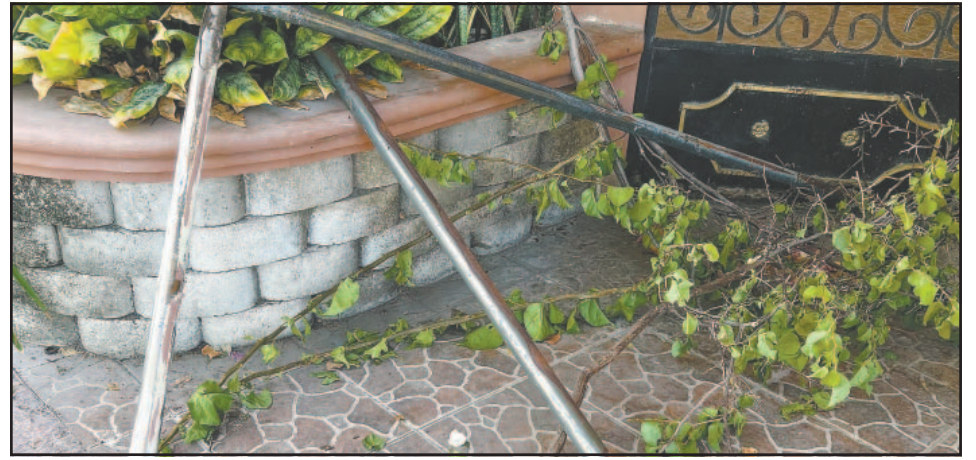
Un camión de carga derribó parte del tendido eléctrico del conjunto habitacional.
