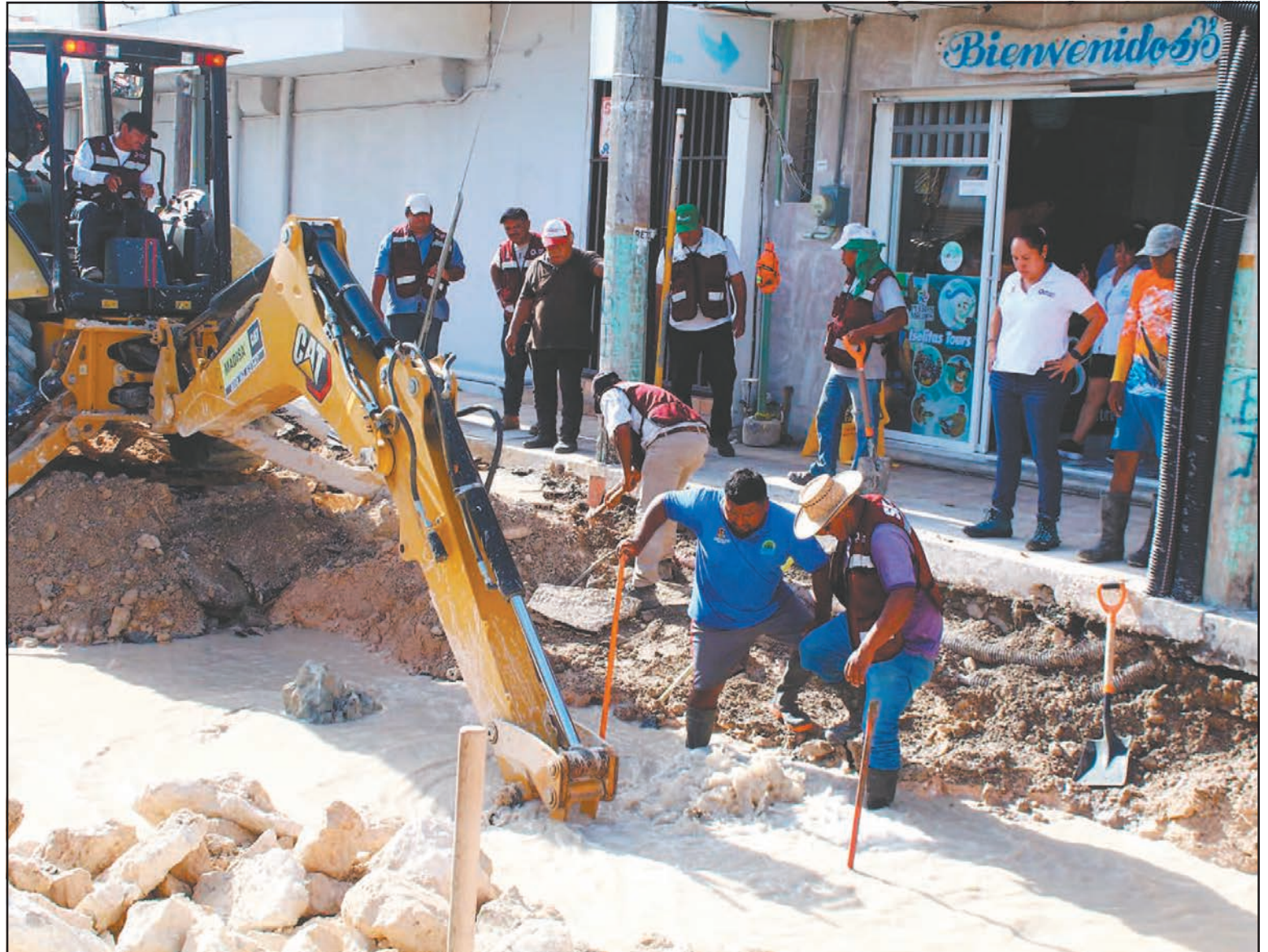
Entre los proyectos previstos antes de concluir el año se encuentra el Barrio Mágico de Chetumal y rehabilitación de la Av. Insurgentes. (E. Martín)
