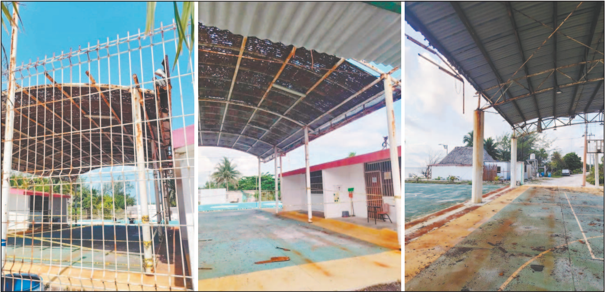
Ciudadanos critican que recientemente el Ayuntamiento anunciara la construcción de 19 nuevas estructuras, pero se haya dejado fuera a la comunidad. (Fernando Olvera)
