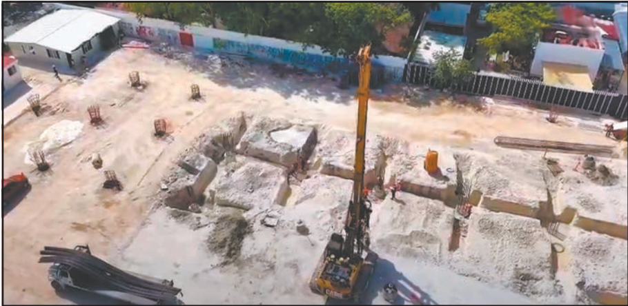
Los trabajos están en la etapa de cimentación de los pilares que sostendrán la estructura.
