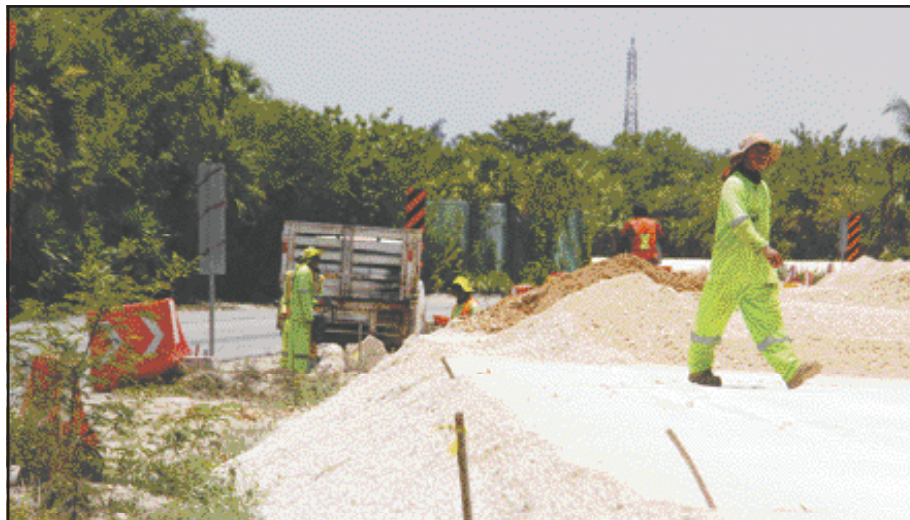
En el “Tramo A” se observan montículos de polvo utilizado para cubrir las tuberías.
