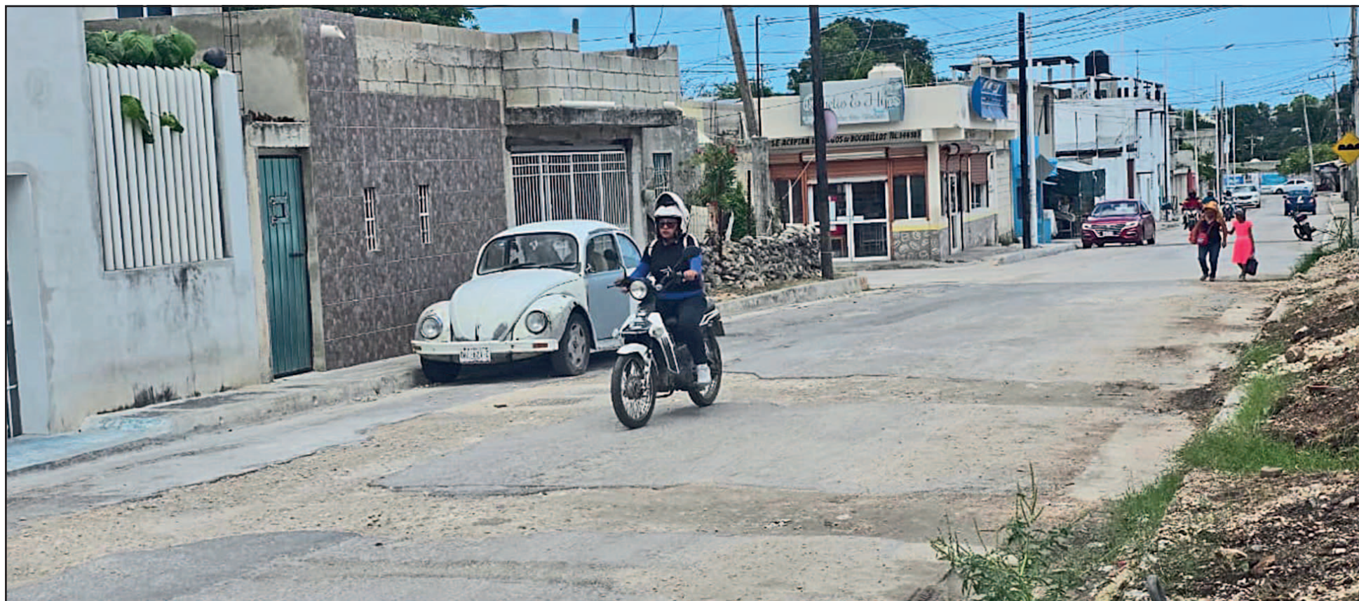
La calle 108 presenta grandes hoyancos y grietas que dificultan el tránsito vehicular, además de representar un riesgo para los estudiantes que utilizan esta vía como paso principal.
