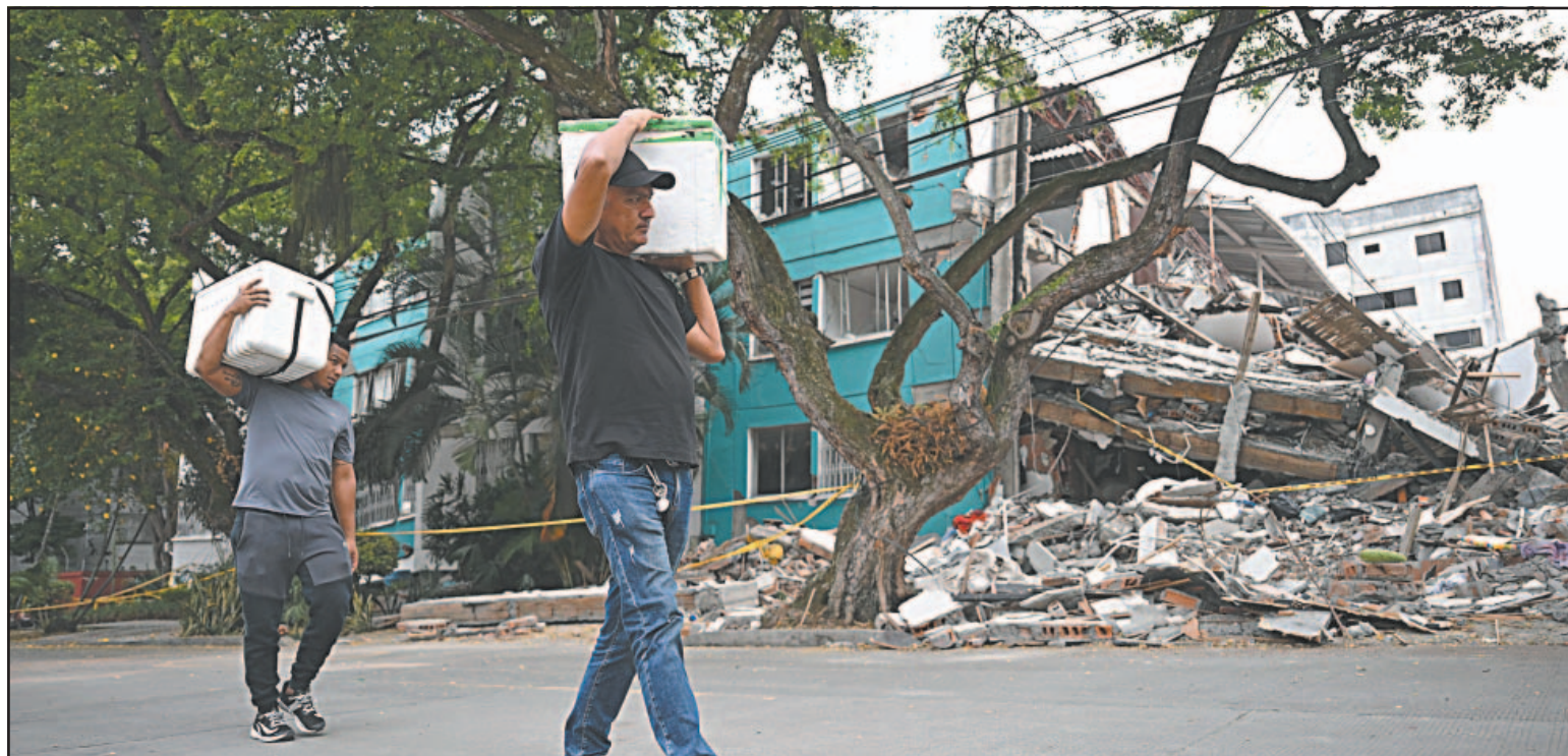
En la capital del departamento de Valle del Cauca hay 46 edificaciones con colapso total, 35 con colapso parcial y más de 2 mil con daños. (AFP)
