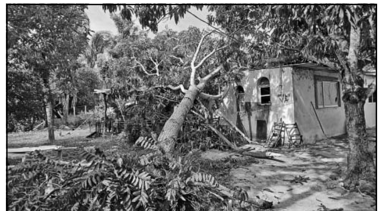
El techo de una vivienda recibió el peso de la planta. (Erik Caamal)
