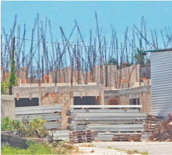
En los municipios construyen las Viviendas del Bienestar.
