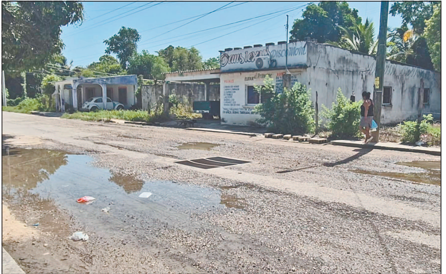
De acuerdo con algunos colonos, en este sector no se han realizado trabajos de mantenimiento desde hace 10 años. (Jorge May Sosa)
