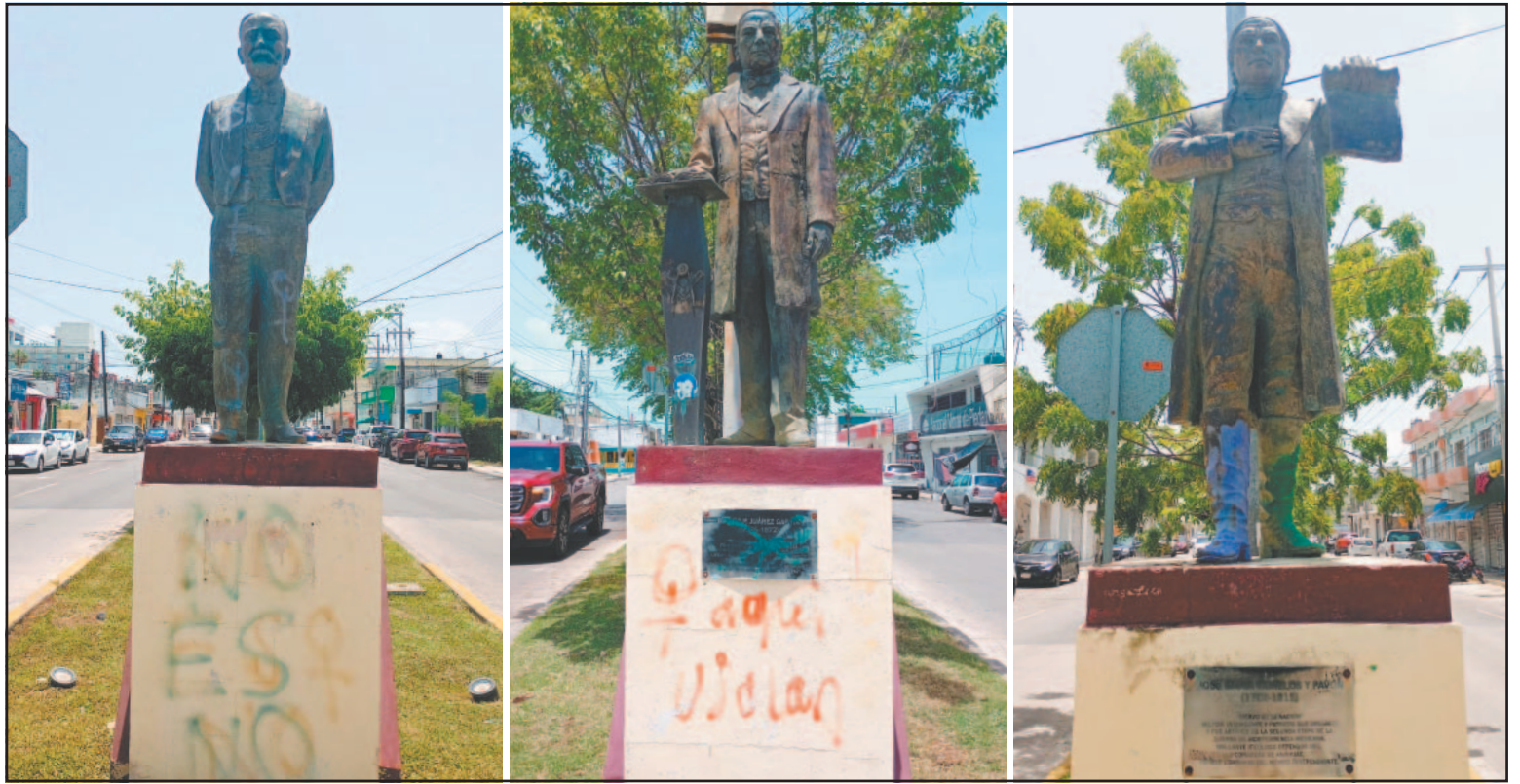
El corredor histórico se ubica sobre la avenida Héroes, donde prevalece el graffiti y falta de mantenimiento a los monumentos. (Fernando Olvera)
