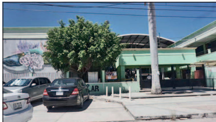
Los vientos mantienen en riesgo de colapso a postes y láminas.
