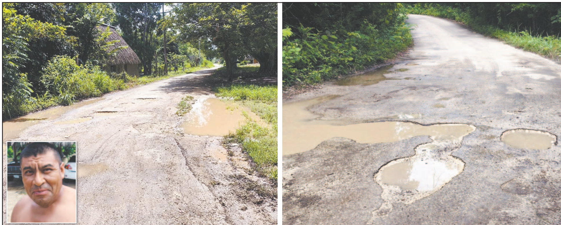
Antonio Góngora reveló que la carretera de 22 kilómetros que comunica con El Martirio, Pozo Pirata y Zafarrancho está llena de baches que la lluvia empeoró. (Lusio Kauil)
