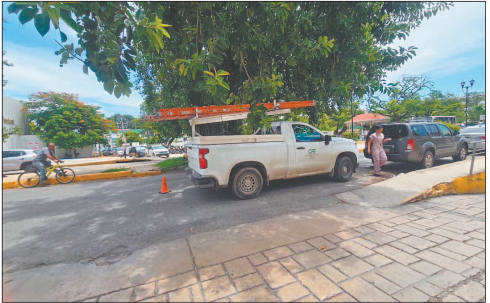
La CFE inspeccionó las líneas subterráneas tras la acumulación de agua provocada por las recientes tormentas eléctricas. (Alejandro Pech)
