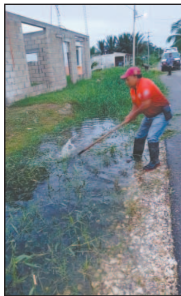
Quitaron lodo, basura y hierba de las alcantarillas. (POR ESTO!)
