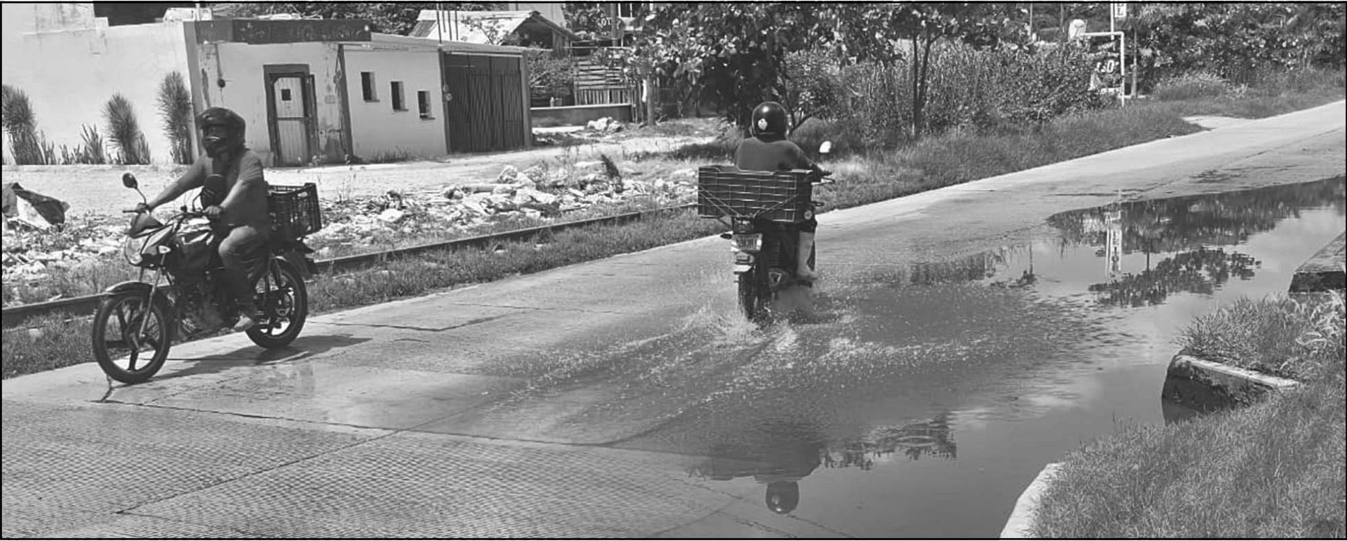
El estancamiento genera verdín en el pavimento y ha provocado accidentes entre peatones y motociclistas; residentes solicitan una rehabilitación integral de la red sanitaria.
