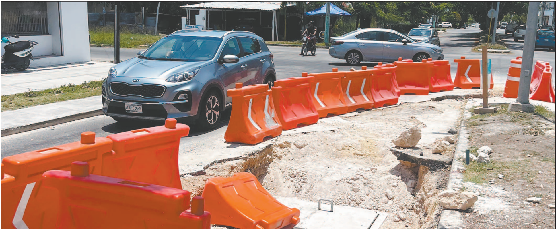
Usuarios reclamaron a la Comisión la lentitud de las obras para construir una subestación, pues llevan varios meses y han dejado calles rotas que afectan la circulación. (Efrén Martín)
