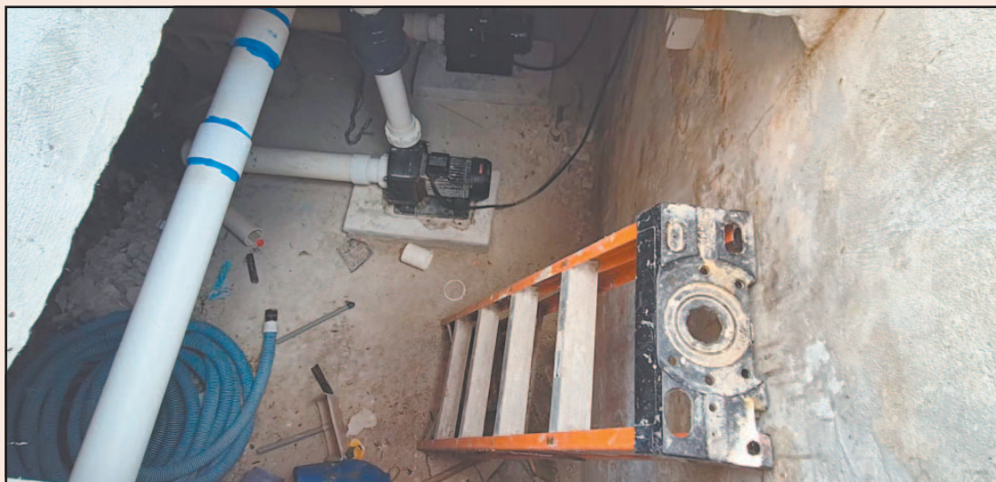
Al revisar la situación, ciudadanos criticaron el descuido al considerar que causaría un accidente.
