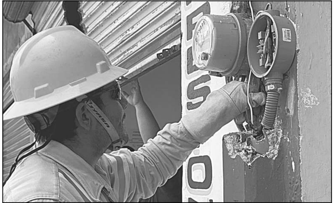
En la CFE fueron inhabilitados dos trabajadores por pedir 70 mil pesos a un usuario al revisar su medidor.
