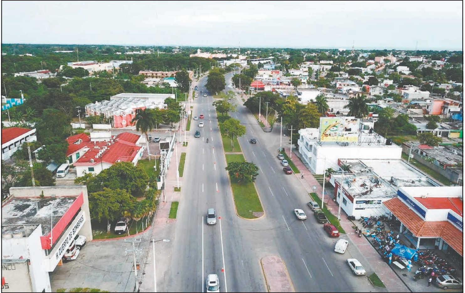
Destacaron que la rehabilitación de esta vialidad no es prioritaria, en comparación con el deterioro de la playa artificial Dos Mulas. (POR ESTO!)
