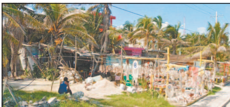
La empresa prometió en vano conectar 180 casas al drenaje. (O. López)
