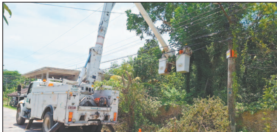
En la colonia Emiliano Zapata I usaron grúas con canasta para cortar ramas. (Justino Xiu)
