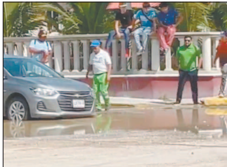
La situación evidenció el mal estado de las vialidades. (POR ESTO!)
