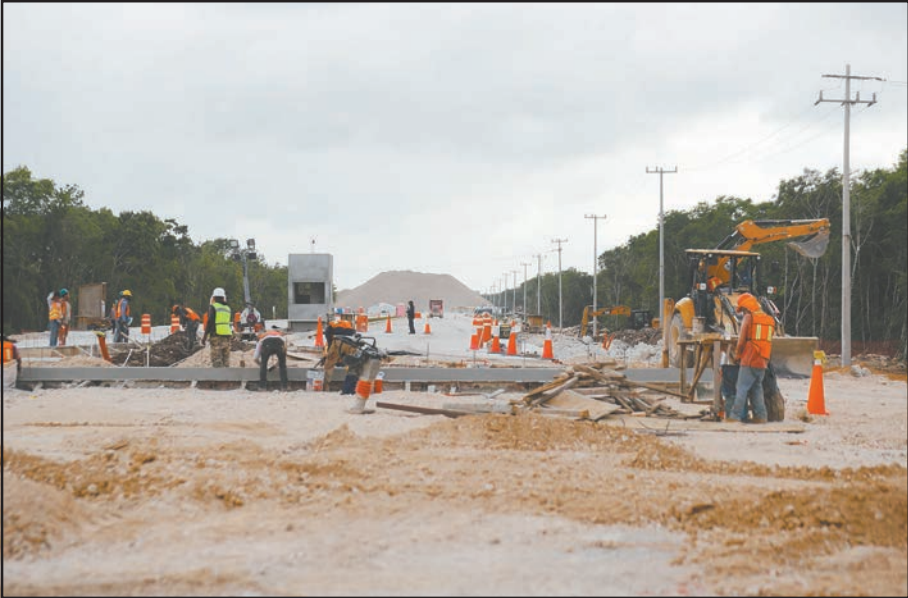
Una cuadrilla pasó de 20 empleados a seis ante la suspensión de trabajos. (R. Flores)
