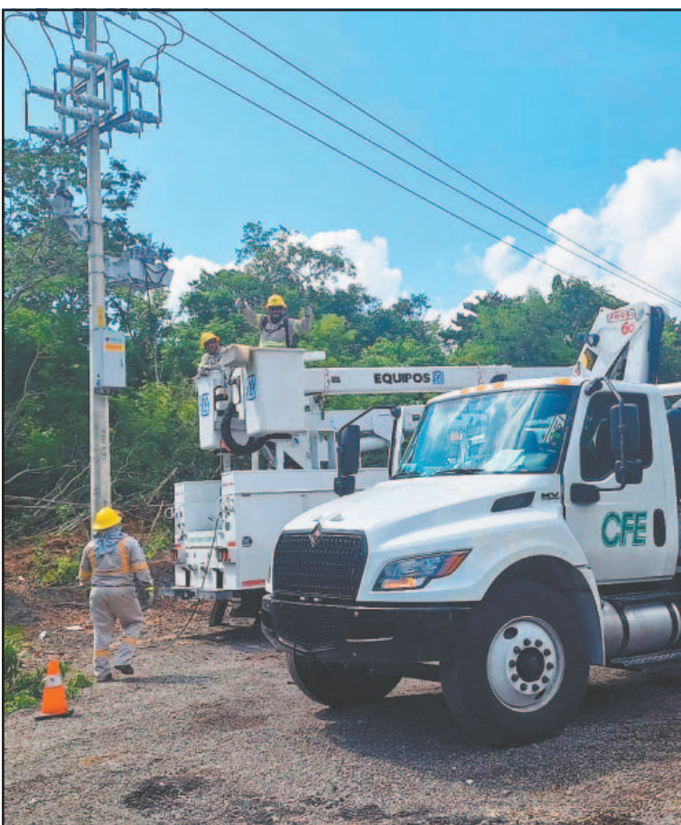
Trabajadores sustituyeron equipos dañados por el uso. (Justino Xiu)
