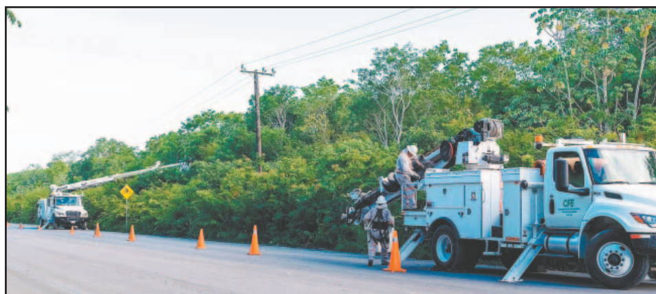
Las intervenciones de la paraestatal iniciaron en la zona hotelera y vía transversal.
