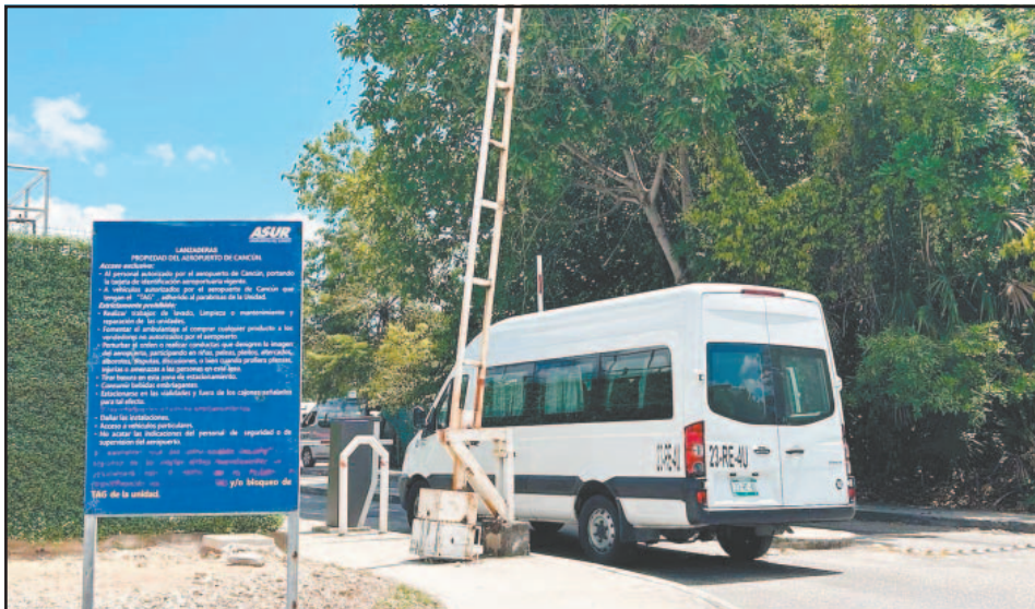
Trabajadores proyectaron que los primeros dos kilómetros queden listos en 21 días.
