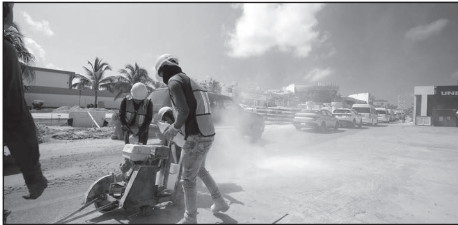
La conclusión está prevista para octubre del 2026; obreros creen que será en enero del 2027.
