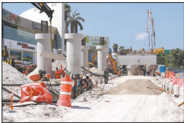
MÁS de 200 trabajadores laboran en el kilómetro 13.5 de la zona hotelera, donde instalan redes de agua potable y drenaje.- (Rodolfo Flores)
