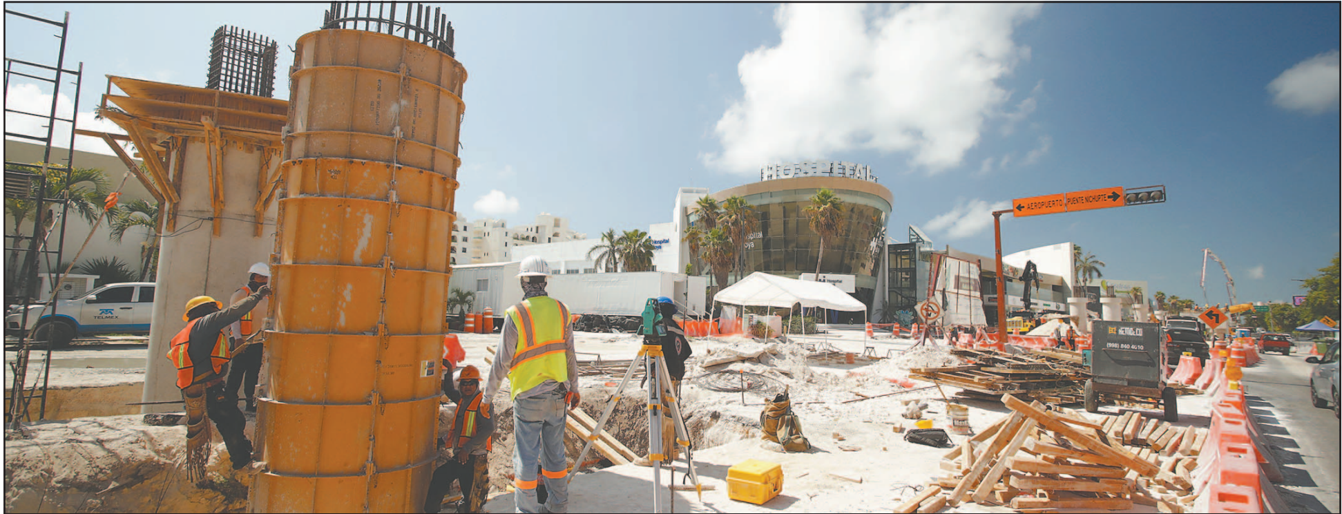
Uno de los principales desafíos durante la ejecución ha sido la infraestructura subterránea existente, como la red troncal de fibra óptica con conexión a EE.UU. y Centroamérica.
