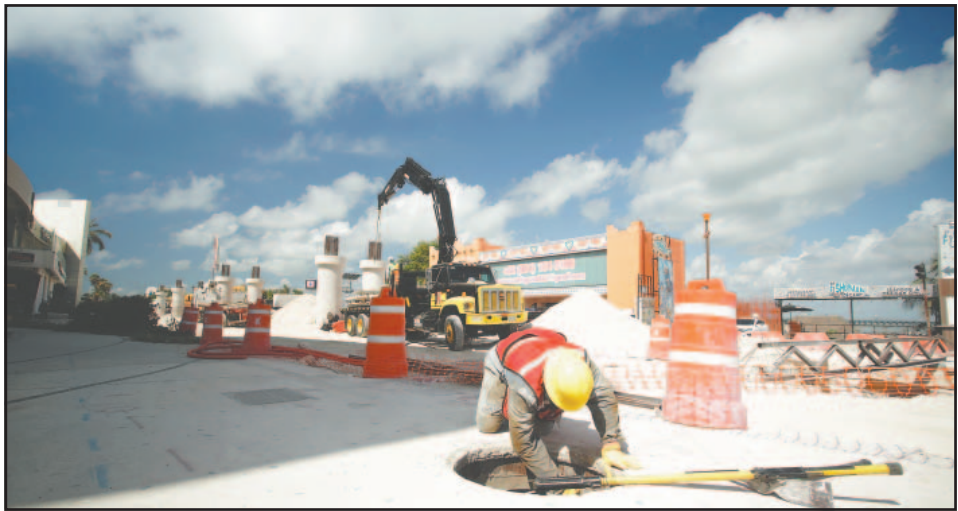
La edificación se concentra en las columnas que soportarán la sección del paso superior.
