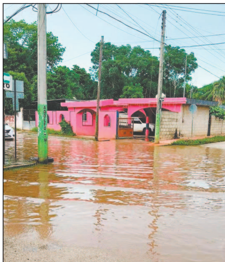
Cuestionaron afectados el deficiente sistema de drenaje. (E. Cauch)
