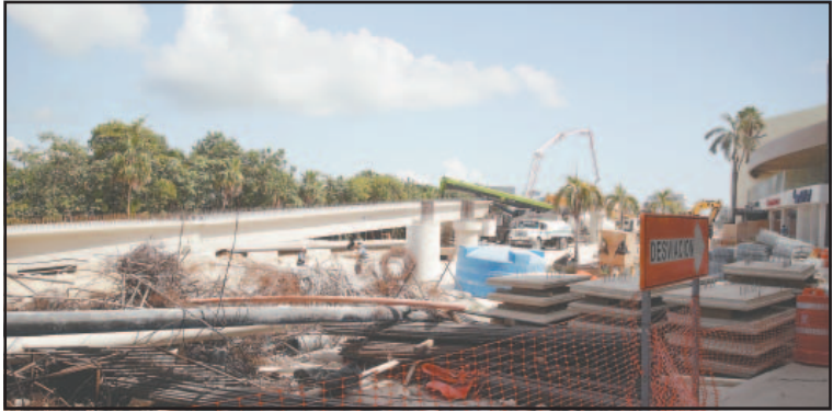
Se instala infraestructura para agua potable y drenaje. (R. Flores)
