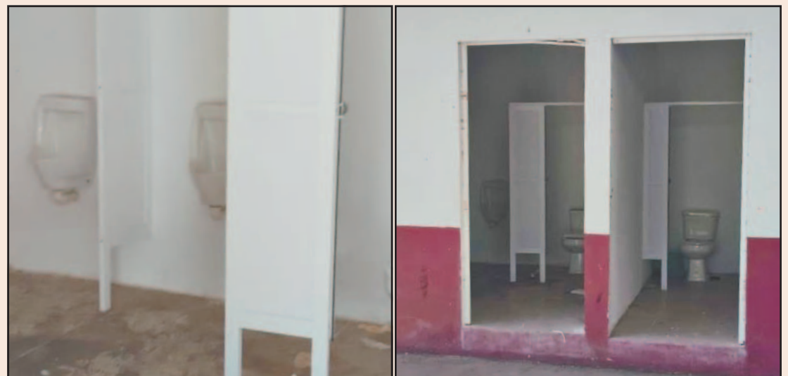
Ante los daños, los vecinos criticaron la falta de vigilancia en este sector de la ciudad. (POR ESTO!)
