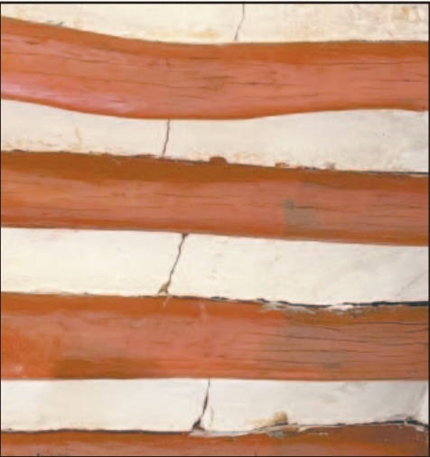
La aplicación de pintura por los creyentes esconde el estado real de la estructura. Demandan un mantenimiento urgente, sobre todo porque la techumbre está pandeada.
