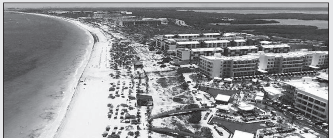
Habitantes destacaron que falta infraestructura de la CAPA en un tramo de casi 3.5 kilómetros. (POR ESTO!)
