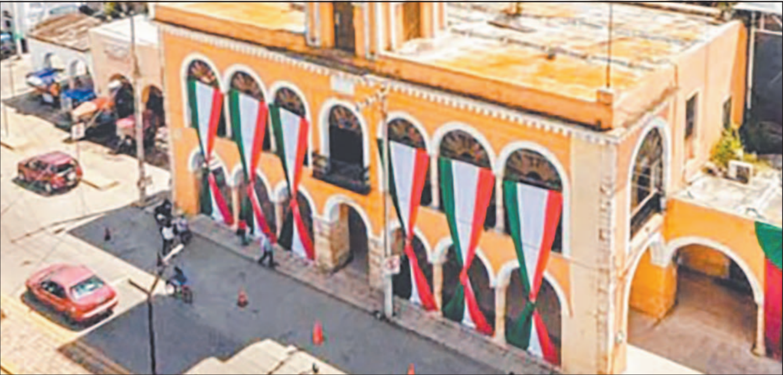
La situación del abandono de la infraestructura generó inconformidad entre habitantes, quienes pidieron la rehabilitación de este espacio.
