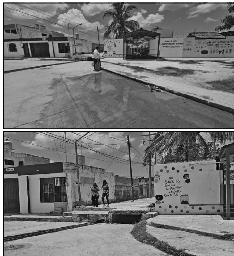
El encharcamiento permanece en una zona de tránsito frecuente.
