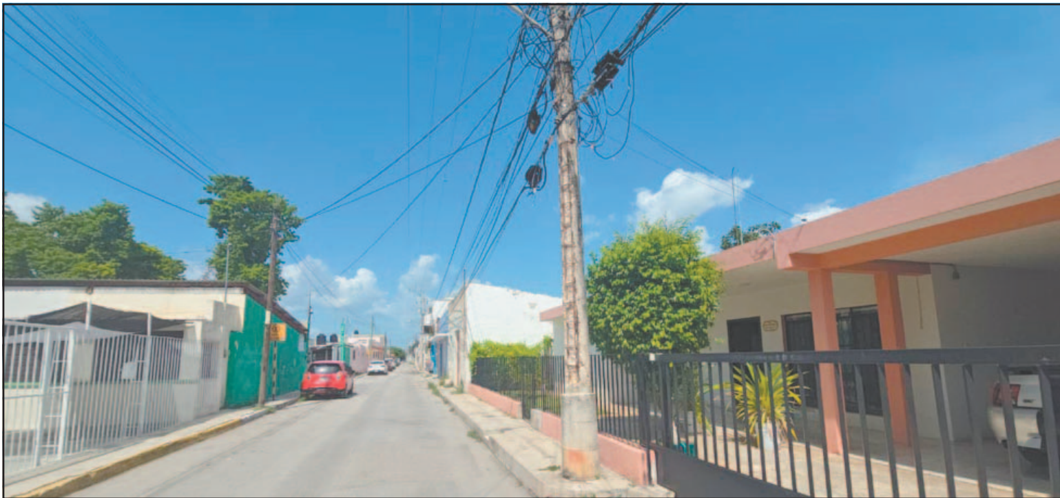
Vecinos aseguran que desde hace años solicitan sustituir estructuras que sostienen cables de media y alta tensión. (Alejandro Pech)
