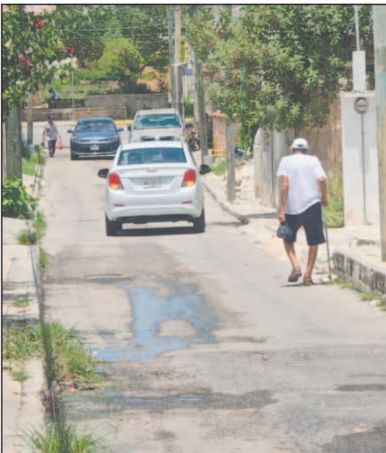
Acusan meses de afectaciones por tuberías rotas. (Alejandro Pech)
