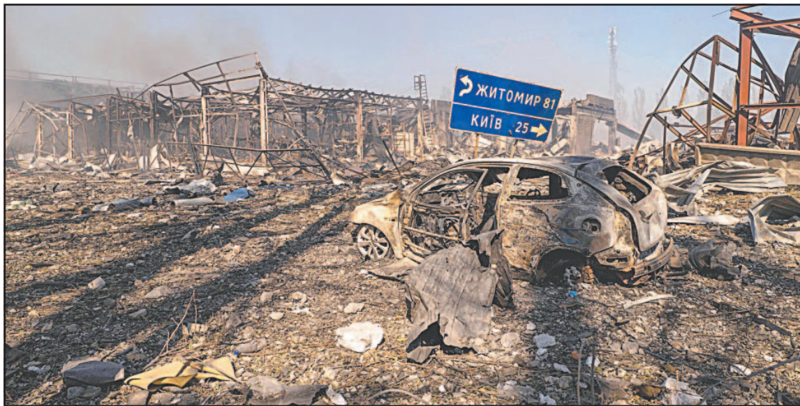
El bombardeo provocó incendios que se propagaron y dañaron 50 edificios residenciales. (AFP)
