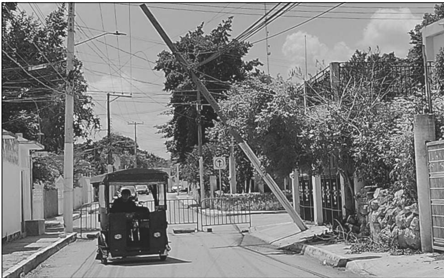
Aunque el paso está prohibido, algunos conductores desacatan la instrucción, y al hacerlo ponen en riesgo su integridad. (Erik Caamal)
