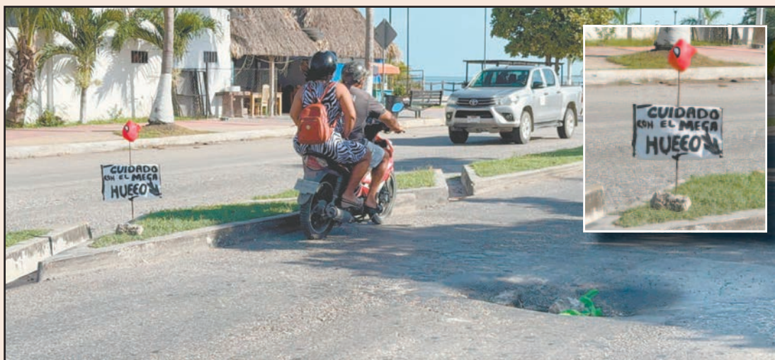
El hoyanco está relleno con piedras, pero representa un peligro para quienes circulan por ahí.
