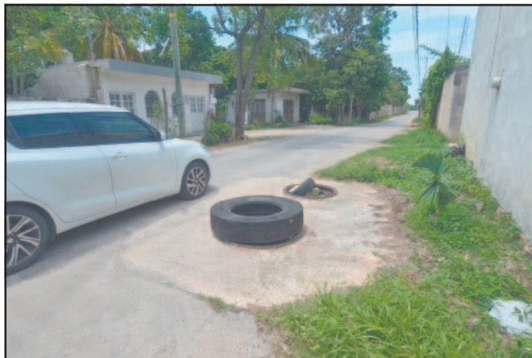
En Imí colocan llantas para evitar accidentes por tapas de CFE desaparecidas.
