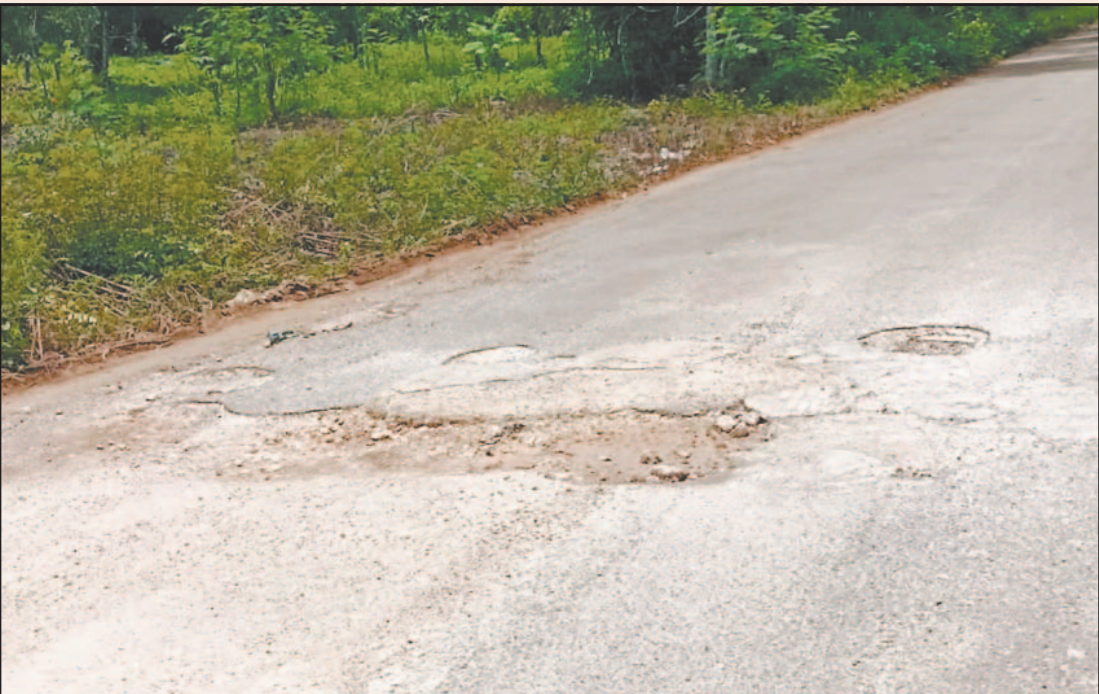
Los ciudadanos comenzaron los trabajos de rehabilitación en un tramo de cuatro kilómetros. (R. Uicab)
