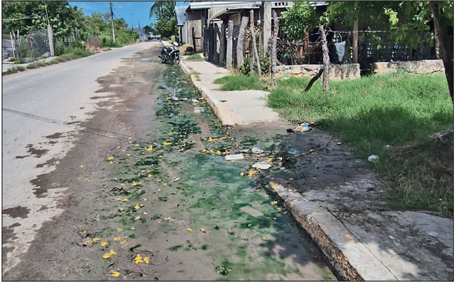
Durante las tardes y noches aumenta la presión en la red hidráulica, hecho que agrava la situación pues “se forma un río”. (Jorge May)
