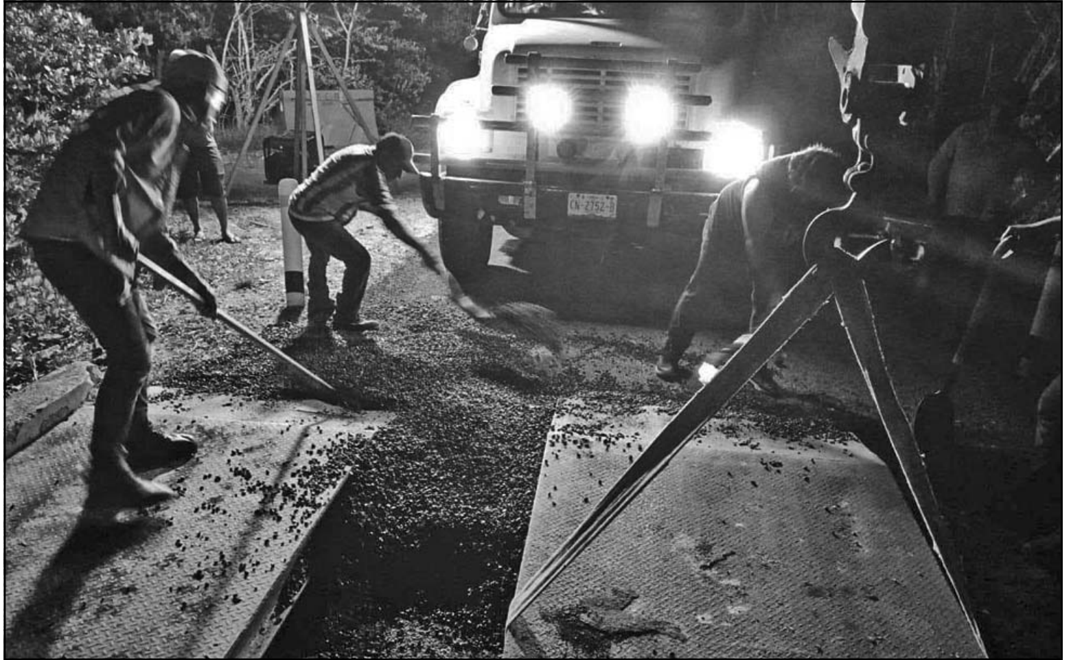
Personal especialista realizó las primeras evaluaciones para determinar el grado de deterioro y emprender las labores de mejora. (POR ESTO!)
