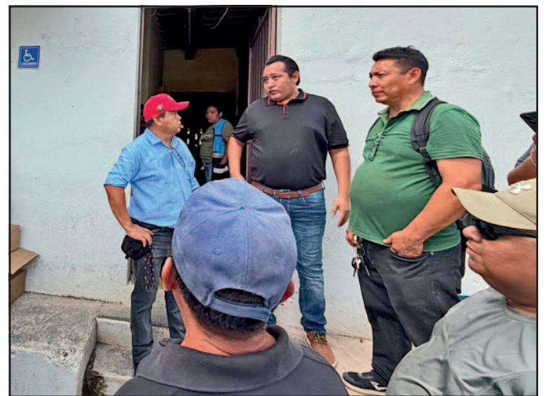
Gracias a la manifestación comenzaron las labores de reparación.
