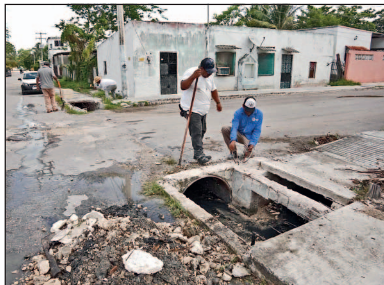
Los trabajadores municipales realizan el cambio de piezas rotas.
