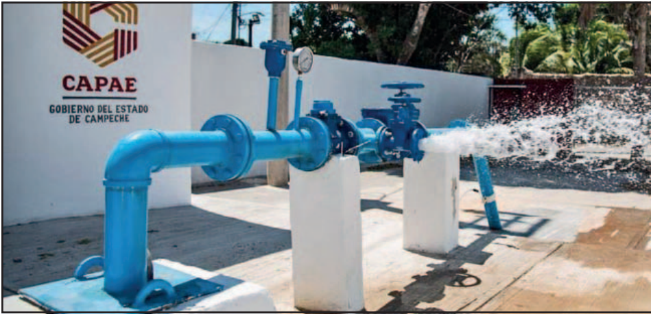
El cambio de infraestructura es para garantizar el abasto a los hogares. (POR ESTO!)
