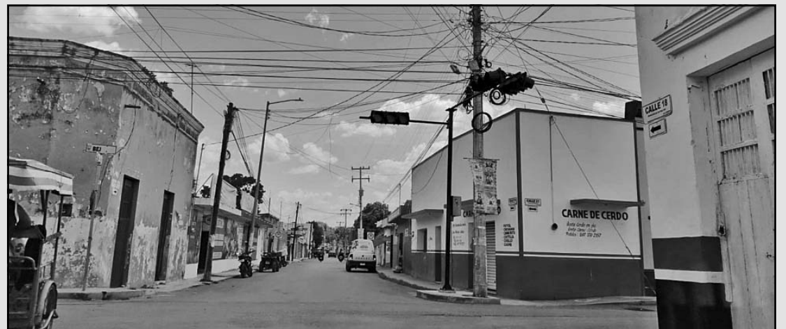
Por más de una hora la comunidad se vio afectada debido al corte de la corriente. (Erik Caamal)
