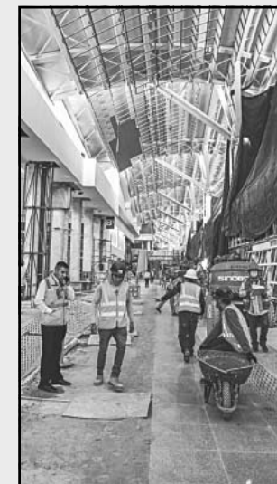
Las obras no suspenderán aterrizajes ni despegues.
