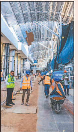
Las obras no suspenderán aterrizajes ni despegues.
