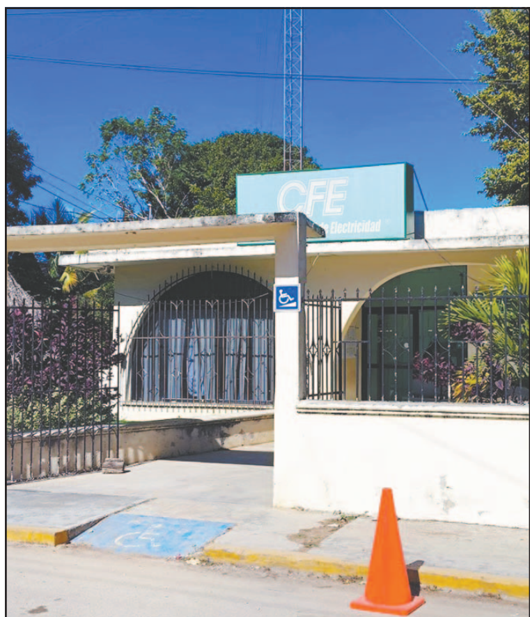
Mediante un escrito exigirán a la paraestatal pagar las reparaciones. (L. Kauil)
