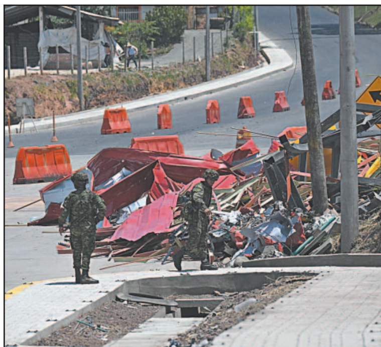
Una caseta de peaje estalló en una carretera cercana a Cali. (AFP)
