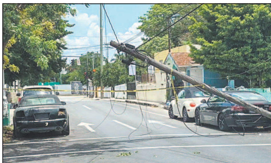
Cables atravesados en la esquina de las calles 16 con 20 obstaculizaron el tránsito.
