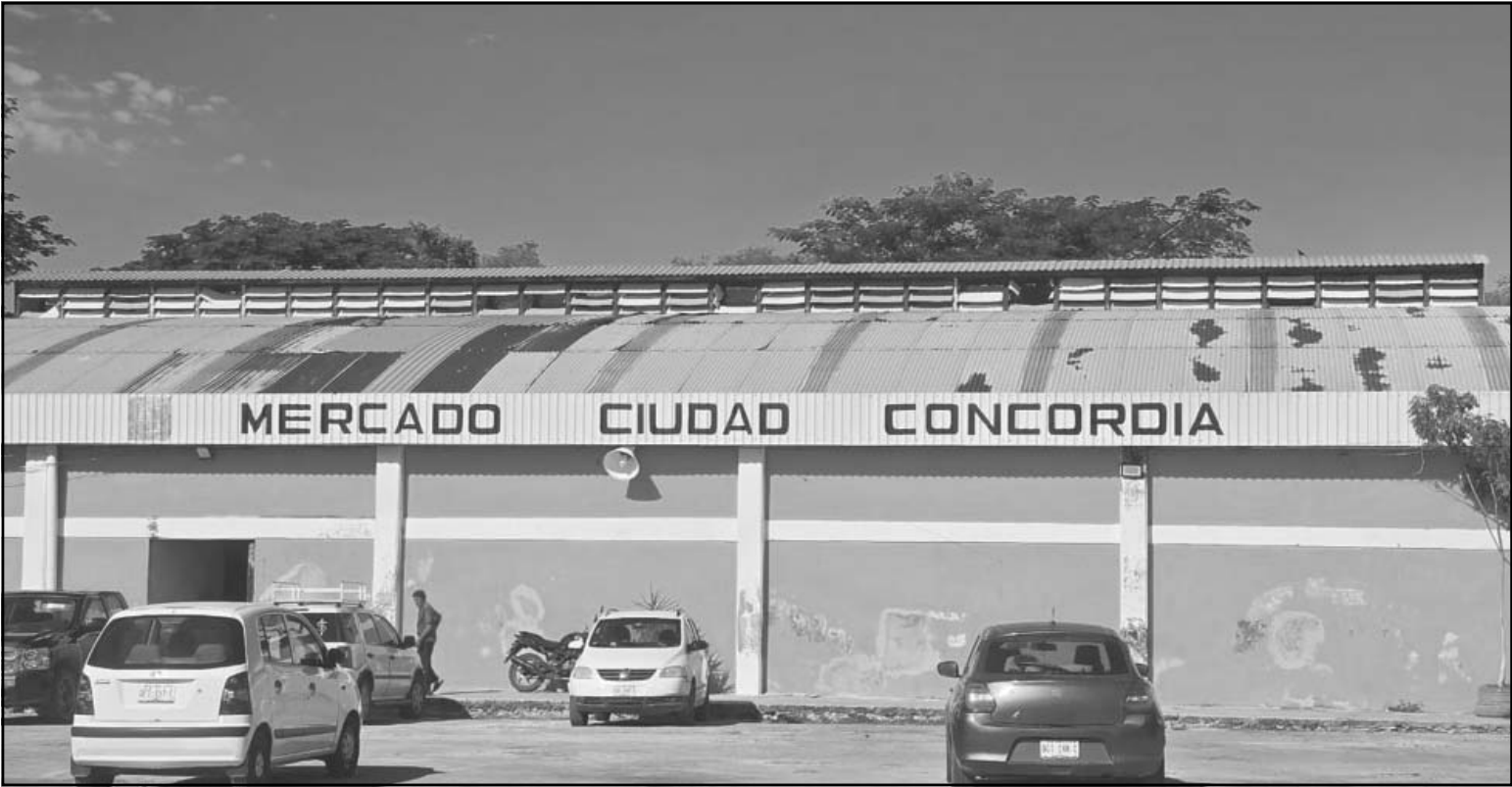
El inmueble conserva la misma estructura de láminas desde su inauguración hace 30 años, según habitantes de la zona. (Alejandro Pech)
