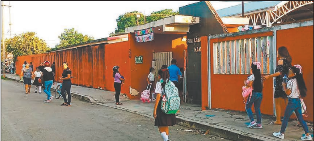
Planteles con pintura desgastada, infraestructura dañada y falta de equipo fue la postal en Lázaro Cárdenas.
