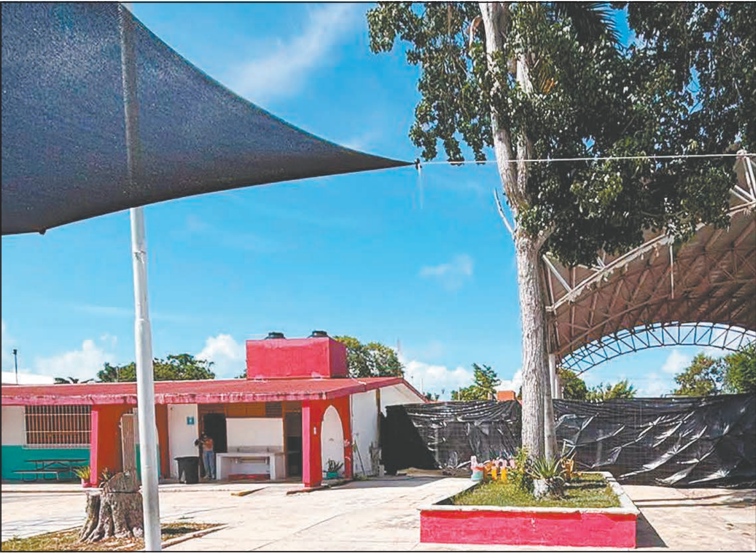
Como medida de presión al Ifeqroo, paterfamilias de la primaria “Ignacio Ramírez”, de Chetumal, no llevaron a sus hijos debido a obras inconclusas.
