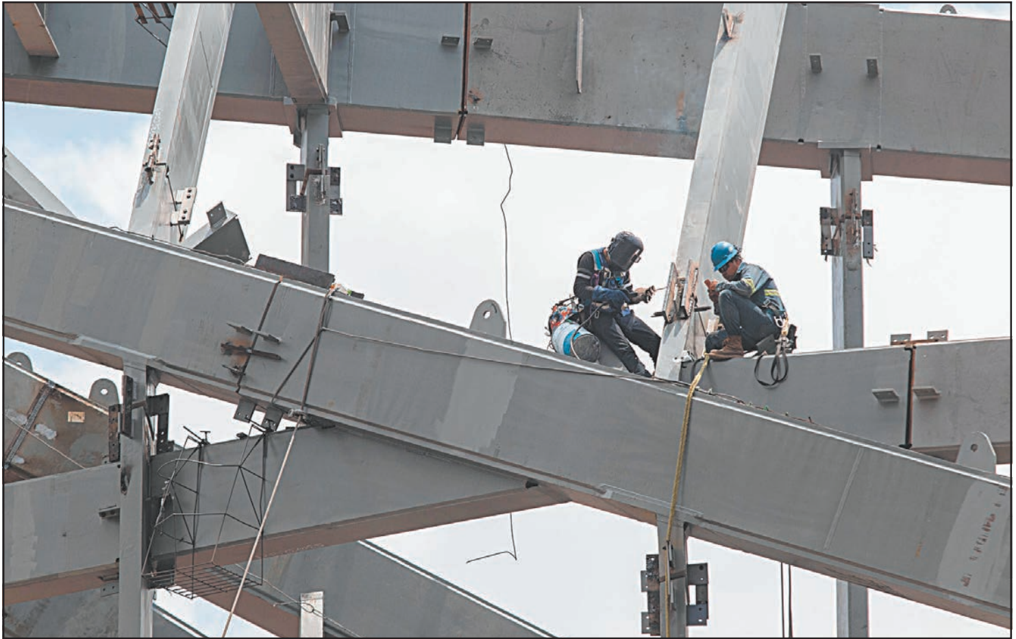
Anticorrupción precisó que, con las nuevas reglas, podrá contabilizarse el valor del metal originario incorporado a la infraestructura. (Cuartoscuro)
