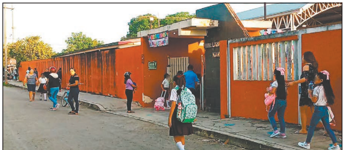
Planteles con pintura desgastada, infraestructura dañada y falta de equipo fue la postal en Lázaro Cárdenas.
