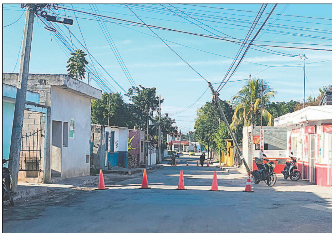
La calle permanece cerrada a la circulación mientras se realizan los trabajos para retirar la estructura.
