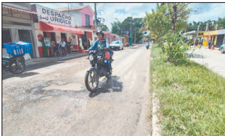
El encharcamiento dificulta detectar la profundidad del desperfecto.
