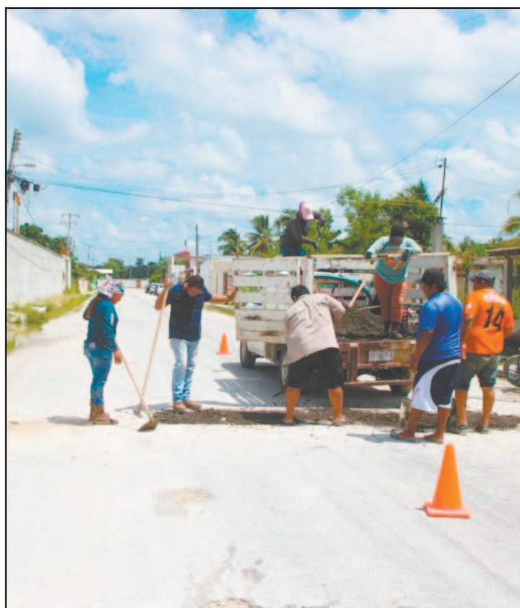
Realizan relleno y nivelación del terreno tras concluir los trabajos.
