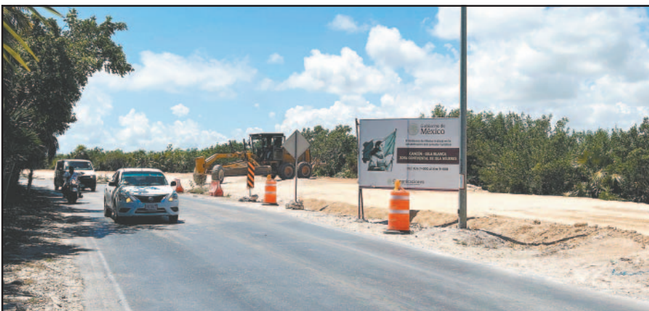
Se construyen más de 25 kilómetros de carretera para unir dos municipios del norte.
