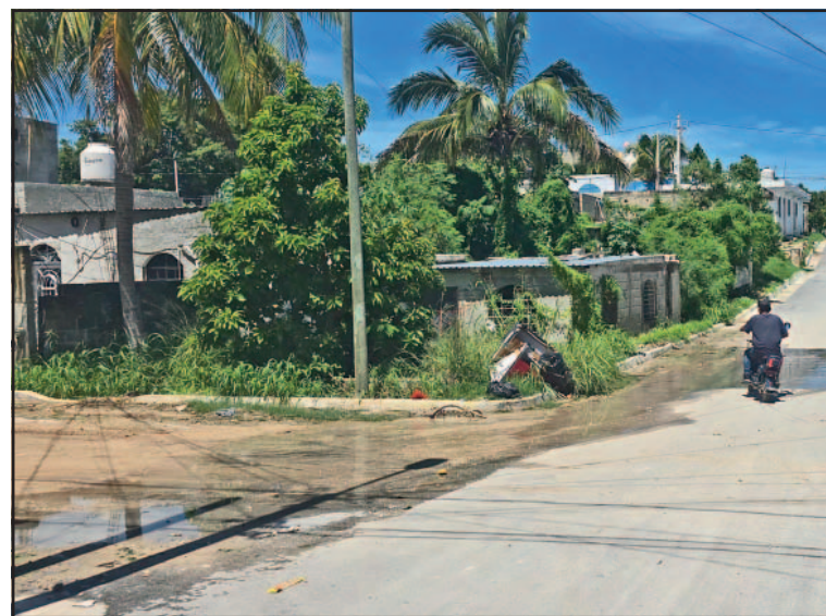
Las calles carecen de sistema de drenaje para las aguas pluviales.
