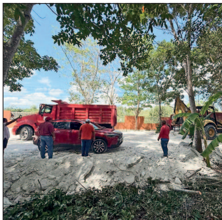
El espacio se llenaba de agua pluvial, la cual se quedaba estancada.
