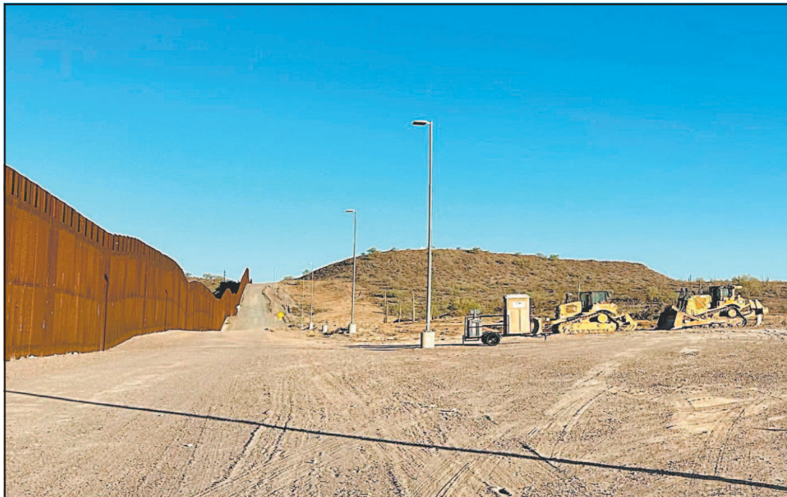
Actualmente se realizan trabajos de medición y ya se observa maquinaria pesada en el área. (Agencias)
