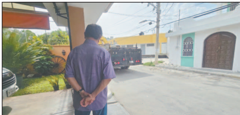
Vecinos habían solicitado durante años la sustitución de la columna deteriorada.
