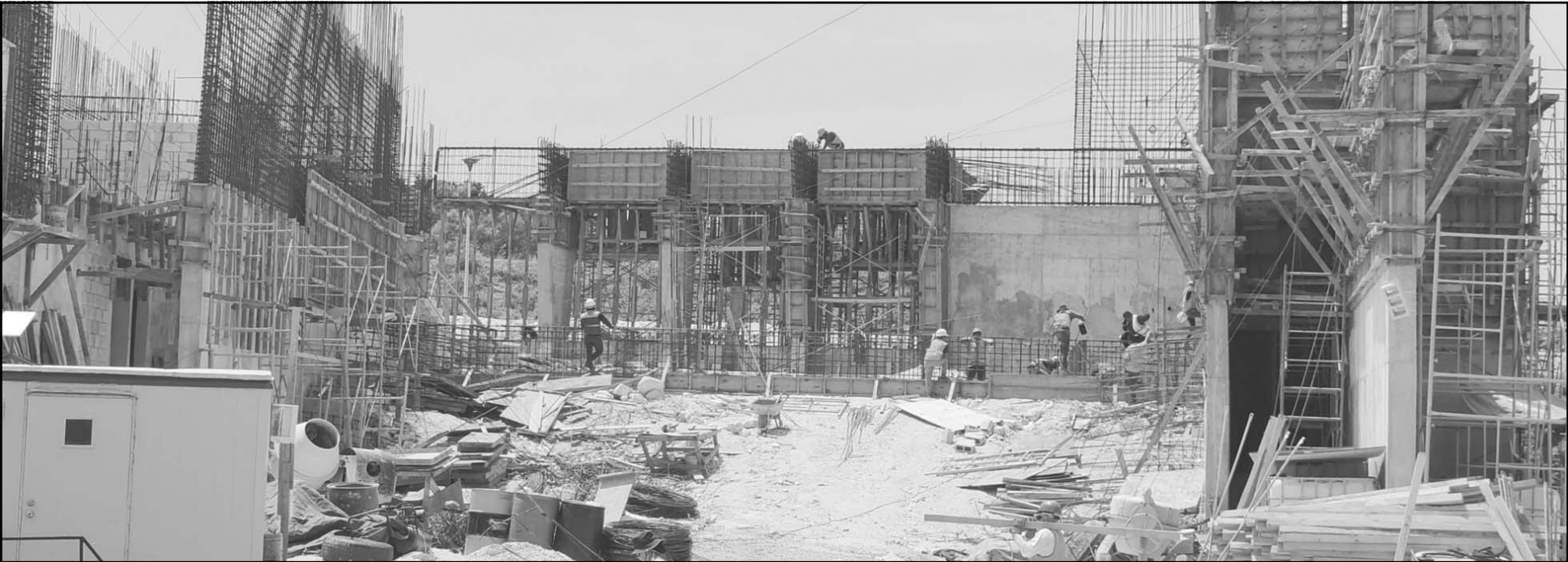
El nuevo Centro Libre se construye dentro de la Utopía ‘Bacab’es’, con una inversión de más de 100 millones de pesos. La primera etapa registra un avance de hasta 89%.
